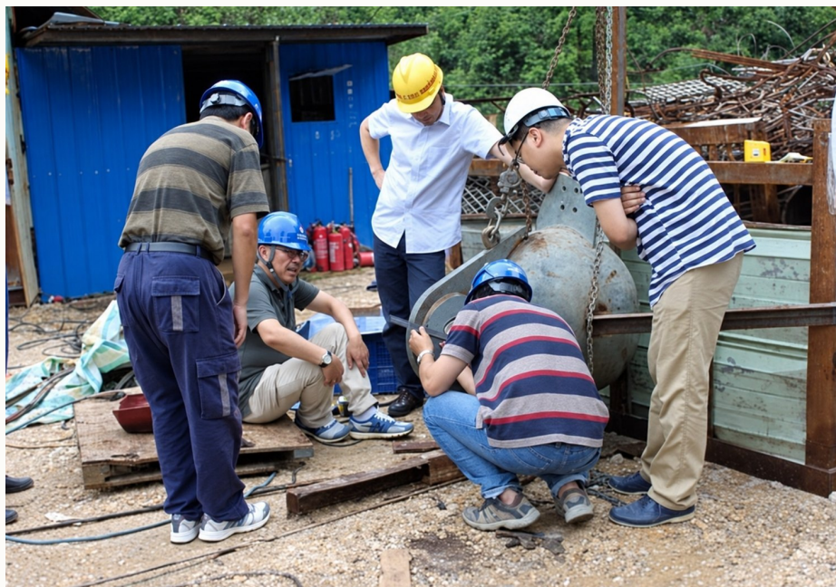
南仁东与工程技术人员进行牵索耳板检测
