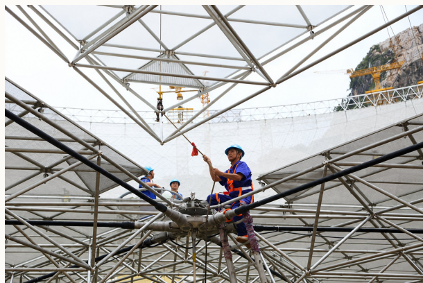
工人安装最后一块反射面单元 二〇一六年七月
