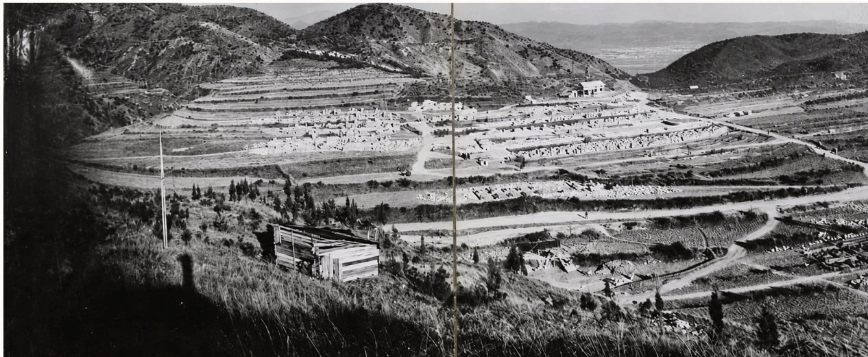
1958年，昆明研究基地的建设现场
